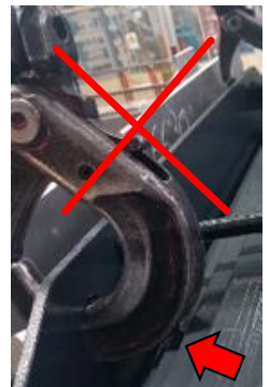
Bild 5-6: Kranhaken liegt an Oberjoch auf
