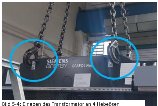
Bild 5-4: Einheben des Transformator an 4 Hebeösen
