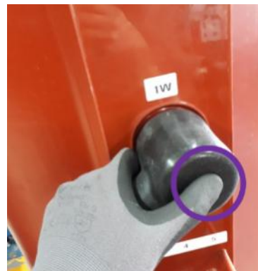
Bild 8-2: Erfüllen der Endposition der Abdeckung an OS-Abschluss
