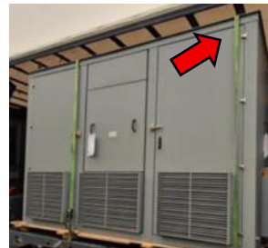
Bild 5-17, 5-18: Ladungssicherung Gehäuse ohne Grundrahmen
