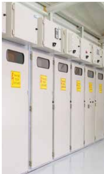
Mellomspennings- koblingsanlegg
