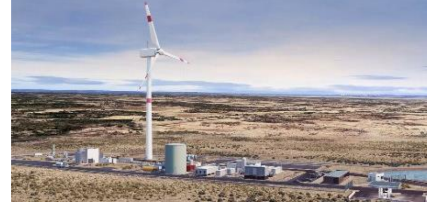
Haru Oni: la primera planta a gran escala que produce e-combustible a partir de hidrógeno verde
